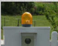
Blinklicht 24 V Warnleuchte blinkt wenn Tor öffnet oder schließt
