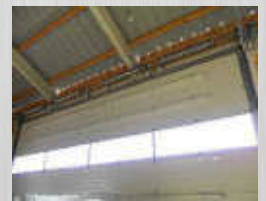
Versteifungsprofile Für mehr Stabilität bei großen Industrietoren
