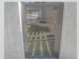
Torbandsseitige Spaltabdeckung inkl. durchgehendem Schlosskasten
