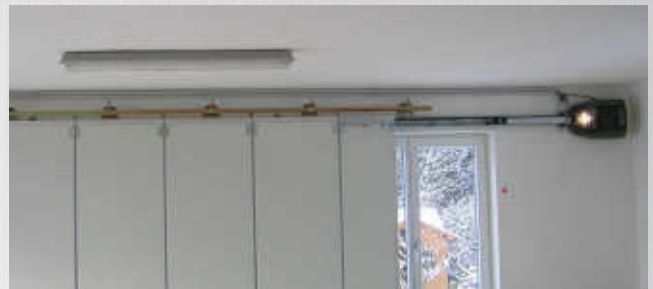
Antrieb an Seitenwand montiert
