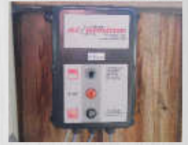
Industrietorsteuerung Für die einfache Torbedienung in der Nähe des Tores montiert (Auf-Stopp-Zu)
